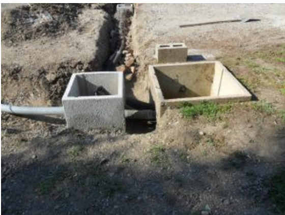
2016 lavori Casa Grande
