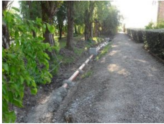
2016 lavori sistemazione cortile Casa Grande
