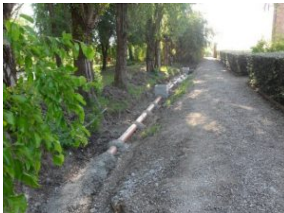
2016 lavori sistemazione cortile Casa Grande
