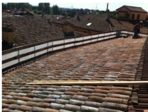
2016 Manutenzione straordinaria Palazzo di Residenza
