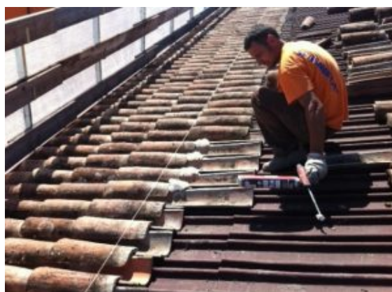
2016 manutenzione straordinaria palazzo di residenza
