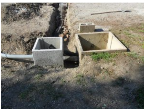
2016 lavori Casa Grande
