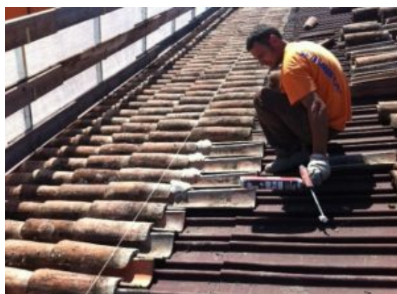
2016 manutenzione straordinaria palazzo di residenza
